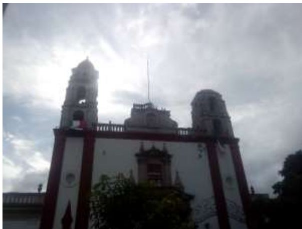
Fig. 1. Iglesia de Santiago Apóstol de Cuautla, con sus dos campanarios dañados
