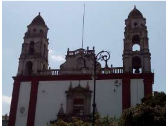
Fig. 1. Iglesia de Santiago Apóstol de Cuautla, con sus dos campanarios
