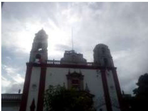
Fig, 12. Iglesia de Santiago Ápostol dañada
