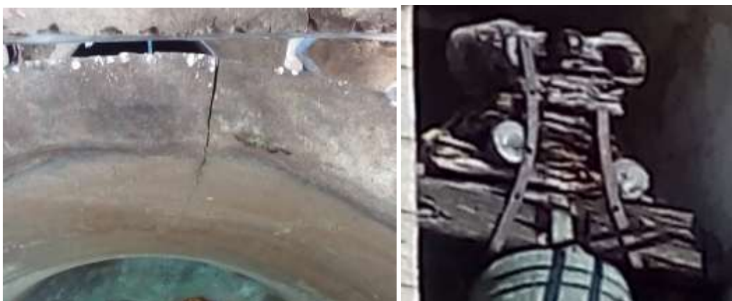
Fig. 6. Detalles de la fractura de una campana y madera dañada de una esquila.
