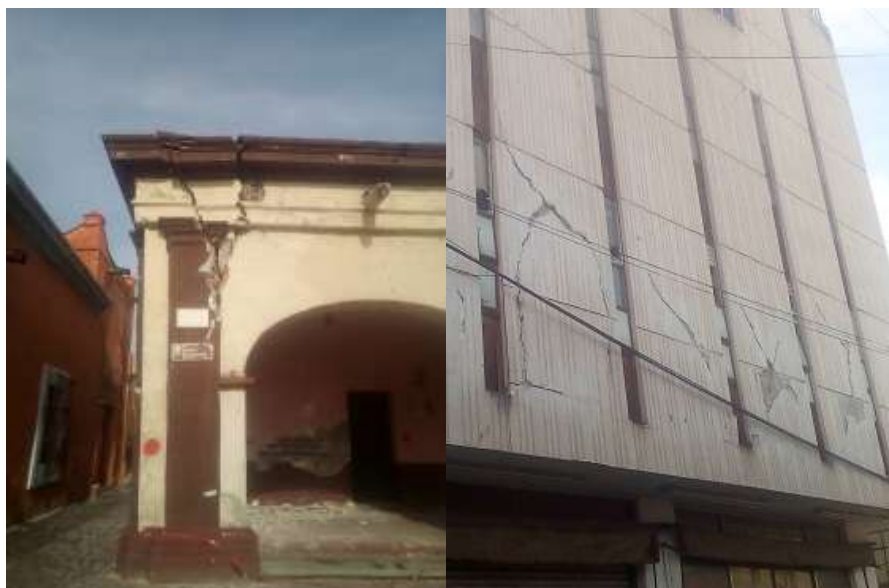
Fig. 8. Cuarteaduras del Portal Matamoros No. 6 y de la calle Villagran.
