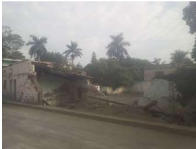
Fig. 3. Ruinas colapsadas después de desalojar y limpiar los escombros
