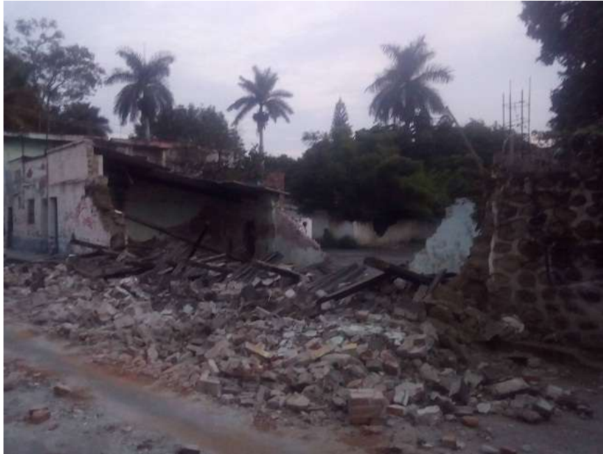
Fig. 1. Ruinas colapsadas por el sismo
