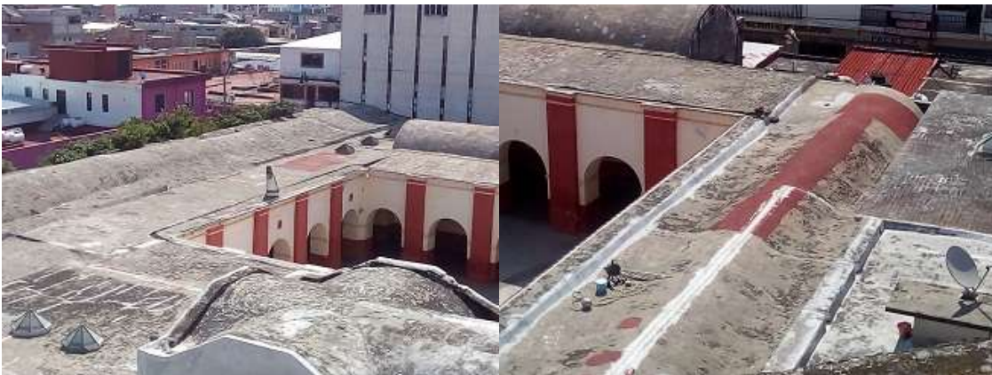
Fig. 9. Vistas del techo del exconvento de Santo Domingo, desde arriba de la iglesia.
