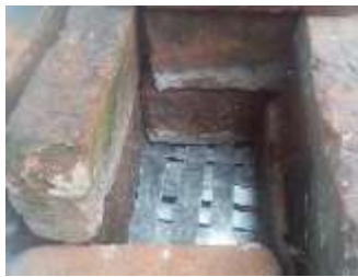
Fig. 6. Hornito de ladrillos
